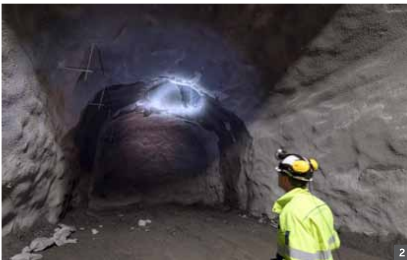
Det finska slutförvaret (1) liknar i mångt och mycket Kärnbränsleförvaret som planeras i Forsmark med deponeringstunnlar (2) där kopparkapslar sätts ner i deponeringshål i golvet (3).
