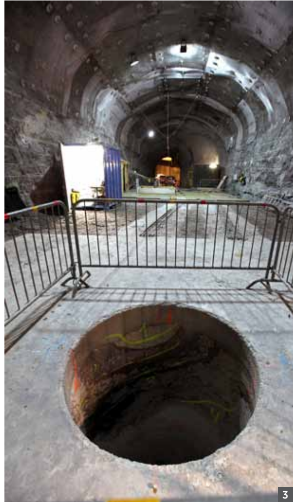
Det finska slutförvaret (1) liknar i mångt och mycket Kärnbränsleförvaret som planeras i Forsmark med deponeringstunnlar (2) där kopparkapslar sätts ner i deponeringshål i golvet (3).
